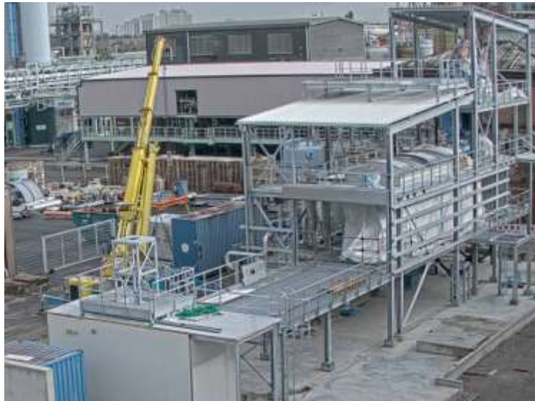
Standort Industriepark Höchst (im Bau)
